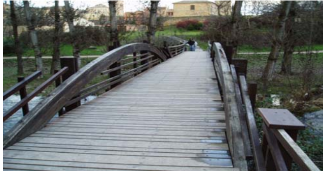
Puente de madera en La Fuencisla
